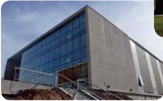
13. Edificio Ciencias Sociales
